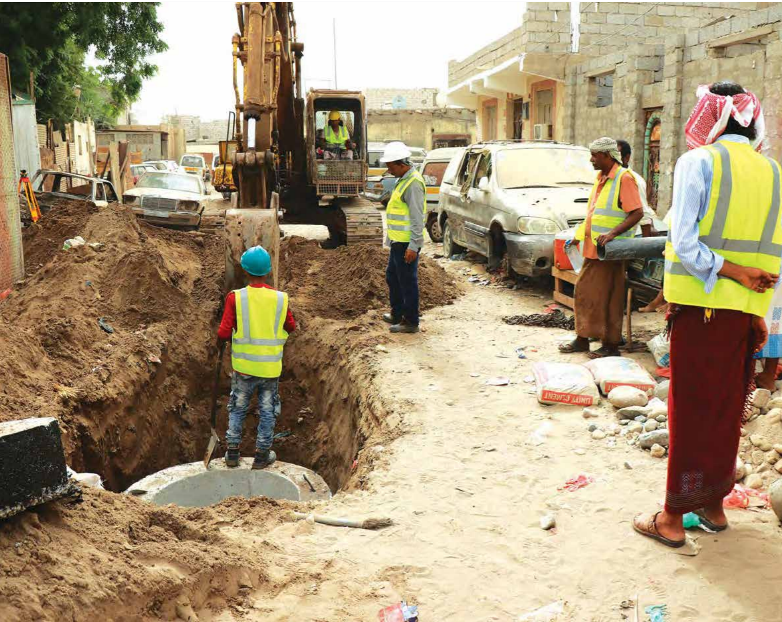
عمال منشغلين في تركيب أنابيب صرف صحي حديثة في دار سعد في إطار مشروع اليونيسف الممول من قبل صندوق قطر للتنمية لتدعيم أنظمة الصرف الصحي والمياه في اليمن
